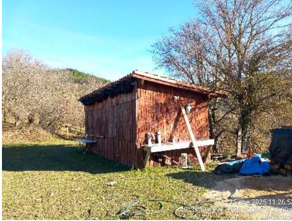
Figura 20: Izqda: Txozna vulnerable ante incendios con fachada de madera. Dcha: Construcción en madera vulnerable.
