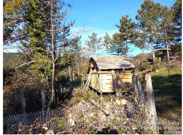
Figura 20: Izqda: Txozna vulnerable ante incendios con fachada de madera. Dcha: Construcción en madera vulnerable.
