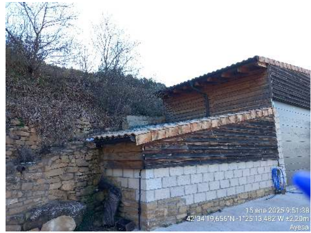
Figura 24: Izqda: Peligrosidad media en iglesia por acumulación de matorral y ciprés columnar muy cerca de la fachada. Dcha: Vulnerabilidad puntual alta en edificación por fachadas de madera.
